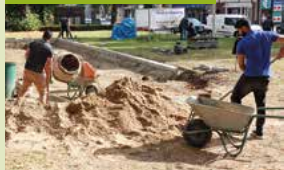
Bau des Bouleplatzes September 2019
