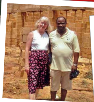
2005: Vor dem zweiten Rohbau
